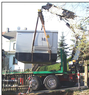
Aufstellung einer NDV800 mit LKW-Kran
