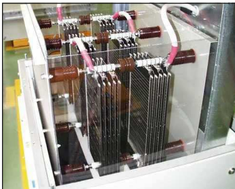
kurzzeitig niederohmige Sternpunktterdung (KNOSPE)
